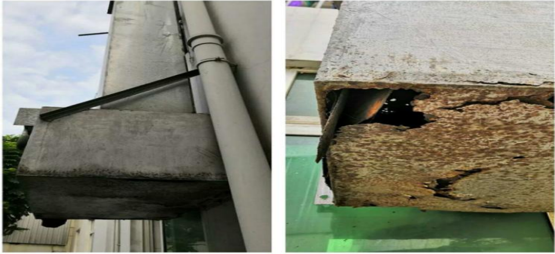
图 4.4.2-25 烟道锈蚀
