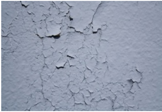
图 4.2.2-3 外墙涂料起皮 图 4.2.2-4 外墙涂料粉化脱落
