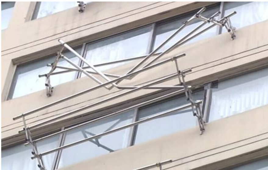
图 4.4.2-9 晾衣架扭曲、变形
