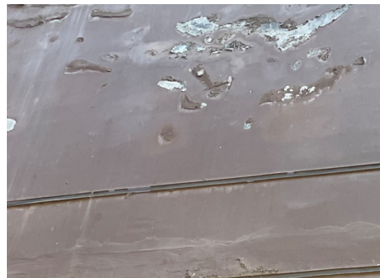
图 4.2.2-18 脱落至抹面层
