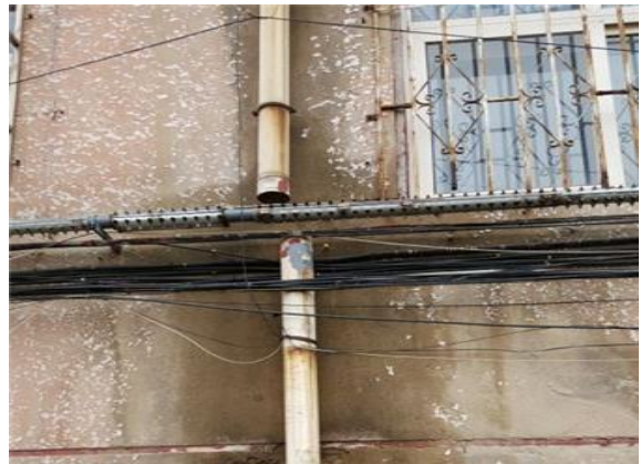
图 4.4.2-22 雨水管脱落
