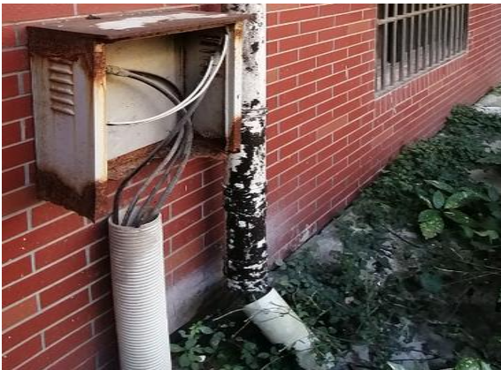
图 4.4.2-21 雨水管破损
