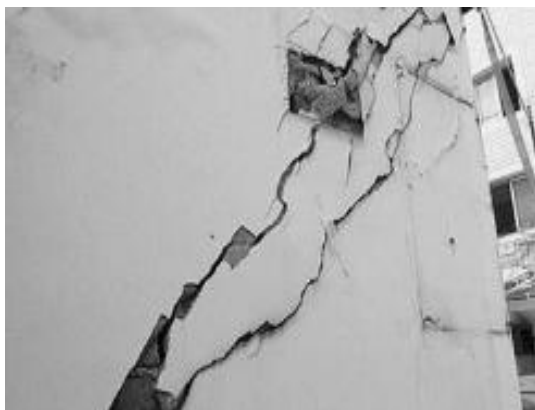
图 4.2.2-1 外墙面裂缝
