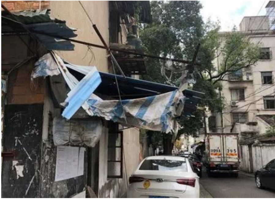
图 4.4.2-8 遮阳棚脱落
