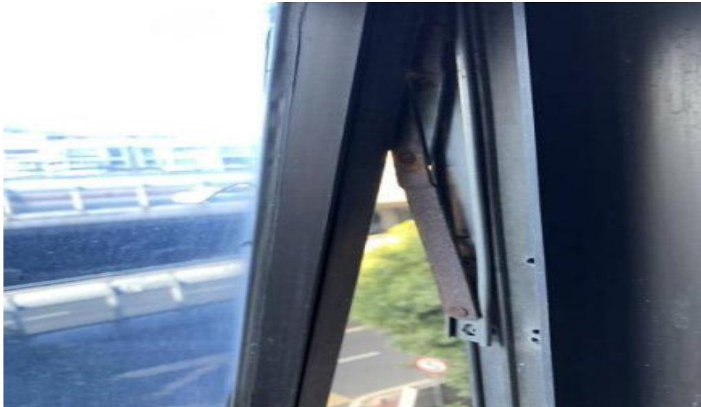
图 4.3.2-13 滑撑固定螺钉缺失
