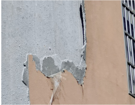
图 4.2.2-19 脱落至保温层
