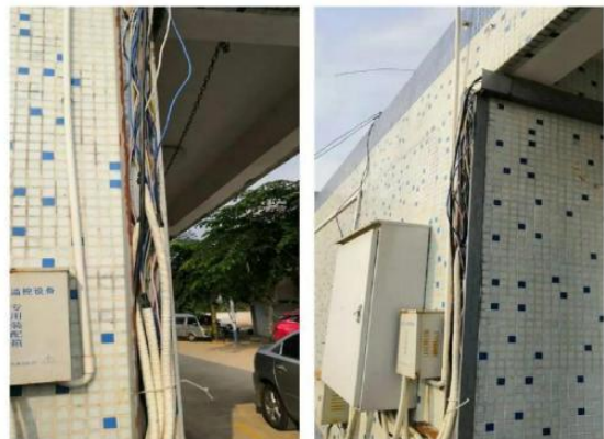
图 4.4.2-24 线槽脱落
