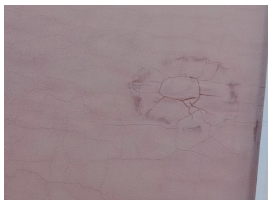
图 4.2.2-2 外墙面裂纹
