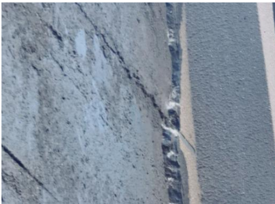
图 4.2.2-7 外墙脱落
