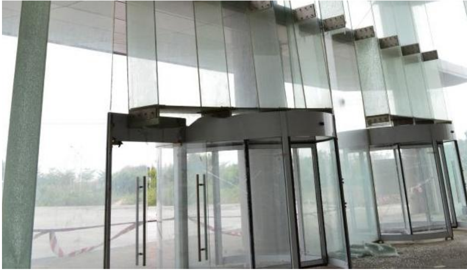
图 4.3.2-9 玻璃肋破裂
