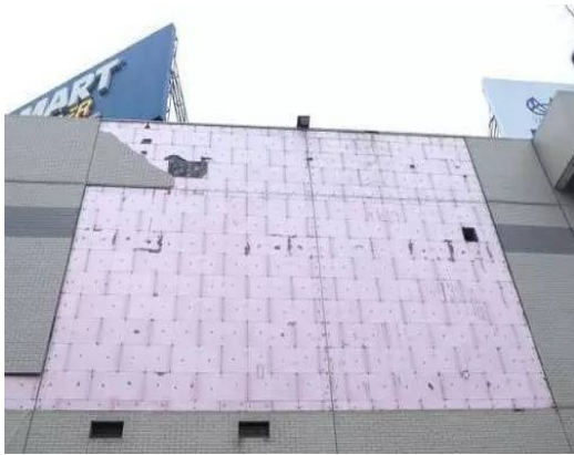
图 4.2.2-21 保温板脱落
