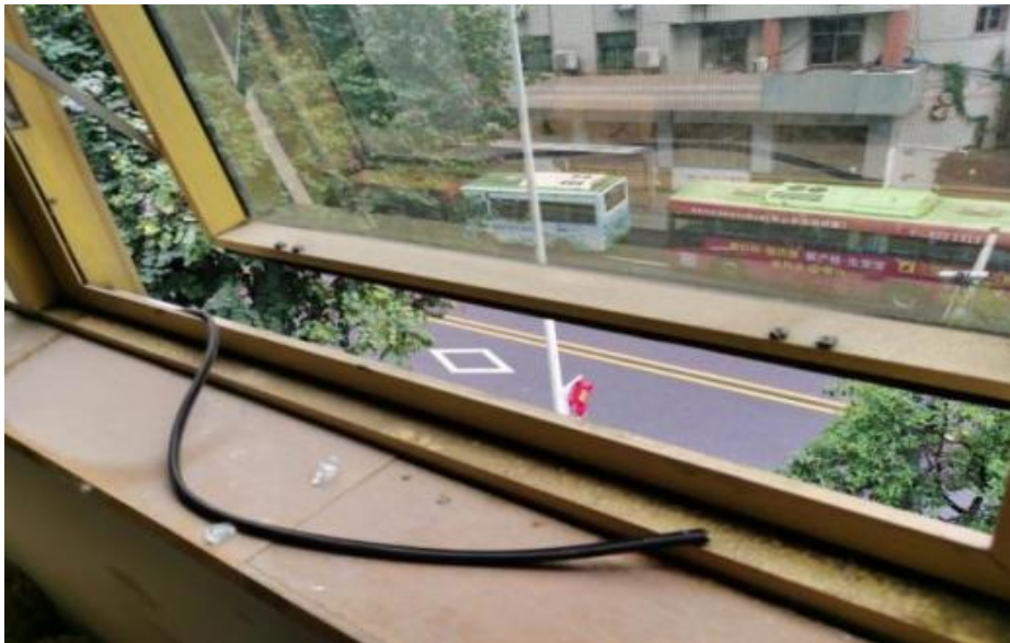
图 4.3.2-17 密封条脱落
