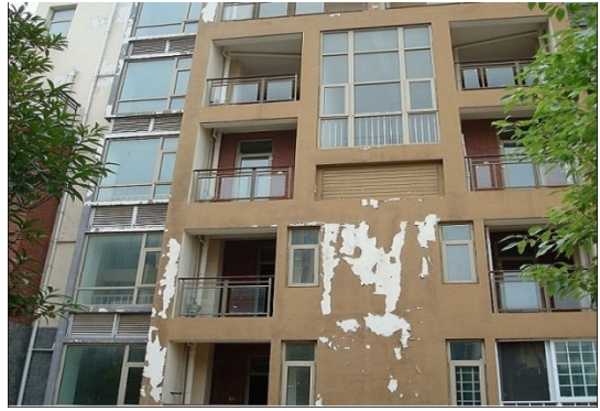
图 4.2.2-3 外墙涂料起皮 图 4.2.2-4 外墙涂料粉化脱落
