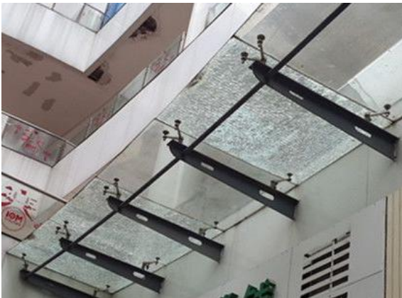
图 4.4.2-6 玻璃遮阳棚破碎
